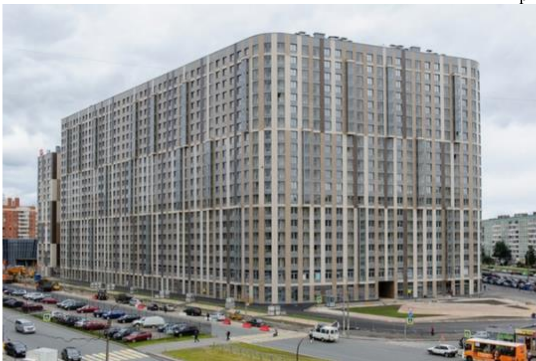
Рисунок 6. МФК в городе Санкт-Петербурге, на улице Хошимина.
